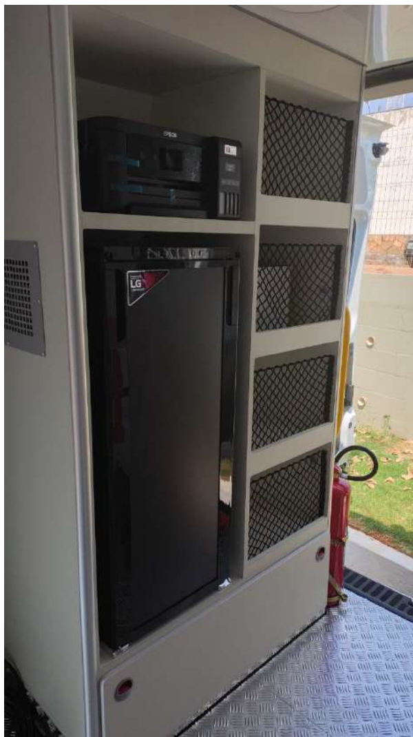
Imagem dos armários com equipamentos
