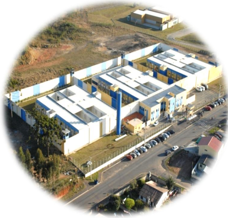
Casa de Custódia de São José dos Pinhais - CCJP
