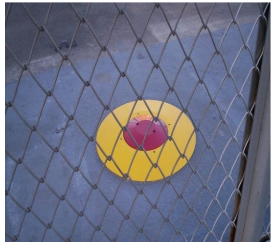
Barreira vertical retrátil, equipamento para bloquear a passagem de veículos nas áreas restritas
